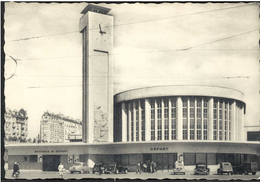
La gare de Brest (Finistère), 1936-1937, Urbain Cassan architecte, Lucien Brasseur sculpteur (Archives municipales de Brest, 3Fi019-055)
