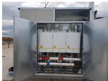
Ccabina SC50 da esterno per installazione caldaie.
